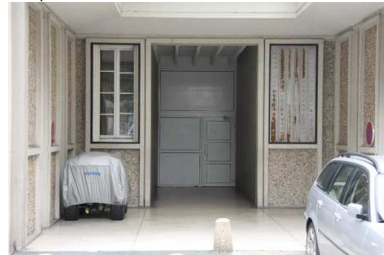
Exemple à éviter : Passage ouvert qui a été fermé
