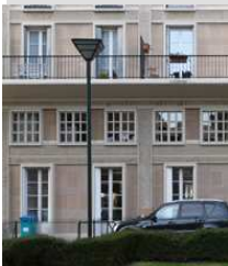
Exemple de luminaire – Ilot V36 rue Victor Hugo
