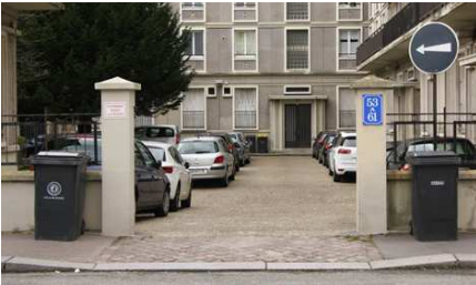
Exemple de seuil d'entrée en pavé de grés récupérés et de revêtement de cour en béton caillouté rue d'Esmauville (qualité de la clôture)
