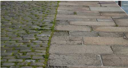
Calpinage de pavés de grés anciens et moellons de granit beige (Quai du Bassin du Commerce)
