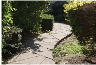
Sentier traversant en béton façon opus
