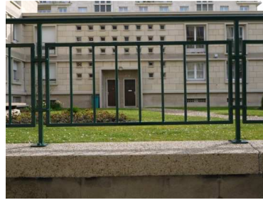
Exemple de garde-corps -V2 rue de Caligny
