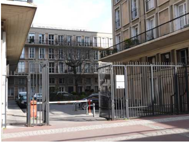
V7 rue Victor Hugo : Exemple de grille et portail à claire-voie d'origine A SUIVRE Exemple de dispositif anti-intrusion de type routier A EVITER
