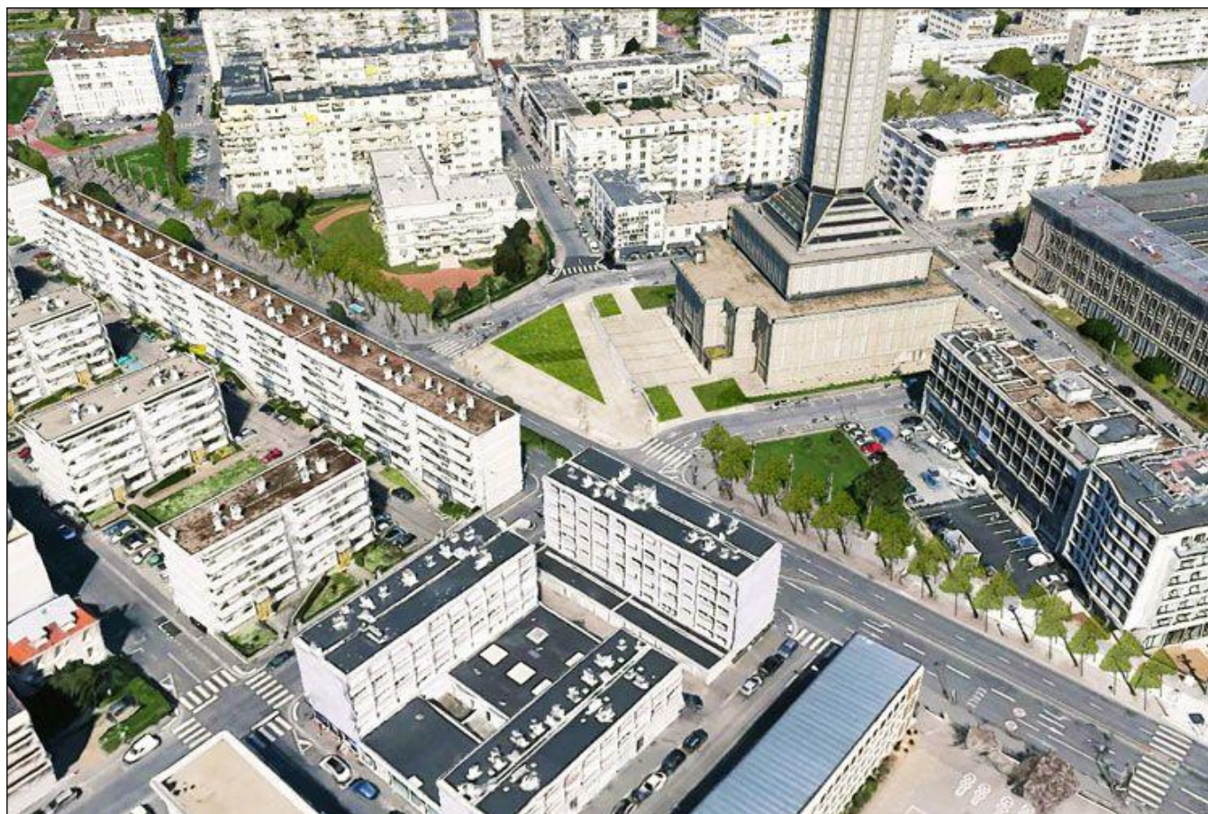
Vue en 3D du futur aménagement. © Ville du Havre
