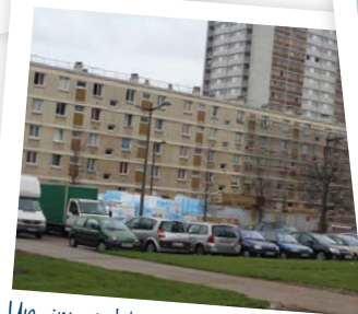
Un immeuble avant travaux.
