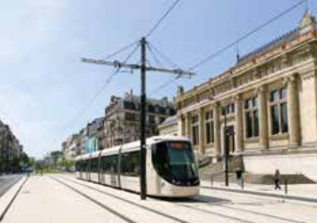
Tramway boulevard de Strasbourg, Le Havre
